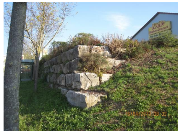
Abb. 5: Natursteinmauer entlang der Backnanger Straße.
