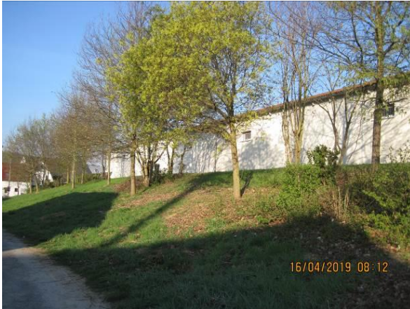
Abb.2: Böschung mit Sträuchern und Bäumen.
