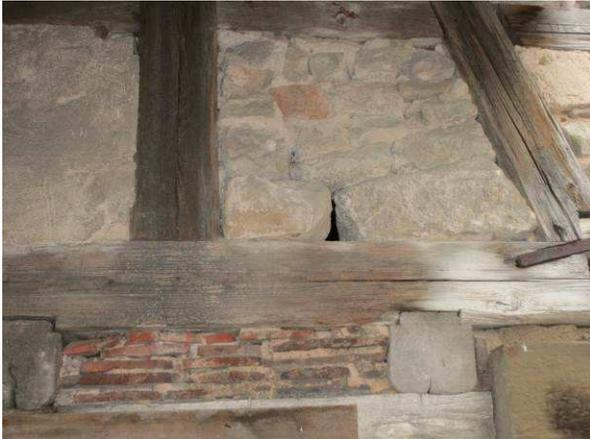
Abb. 10: Mauerspalte an der nördlichen Scheunenseite
