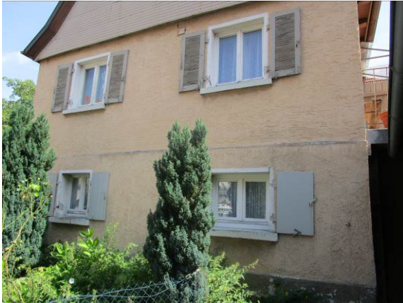
Abb. 2: östliche Front des alten Wohnhauses
