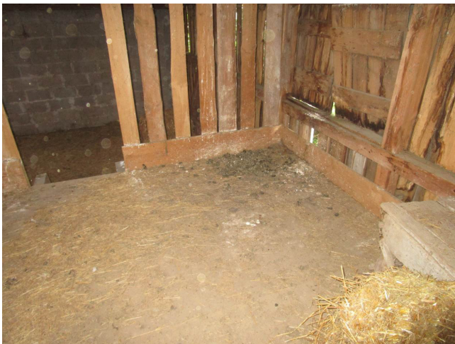
Abb. 6: alte Gewöllereste einer Schleiereule ( Tyto alba ) auf dem Dachstuhl der nordöstlichen Scheune
