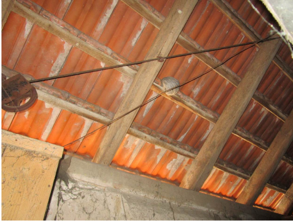
Abb. 8: Altes Wespennest in einer der alten Scheunen.
