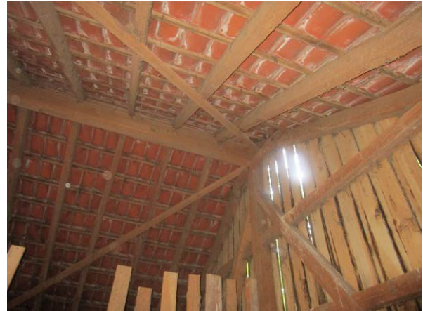
Abb. 3: Dachstuhl in einer Scheune
