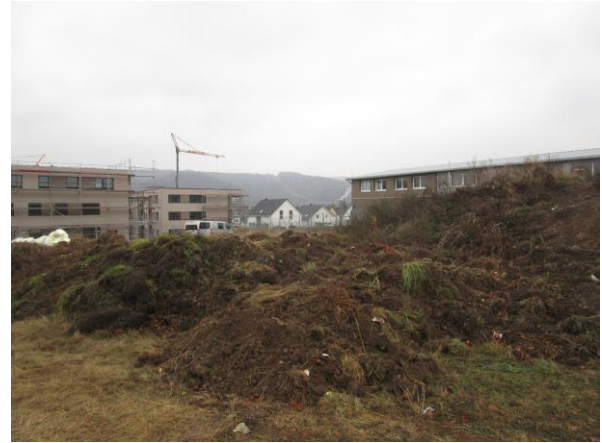
Abb. 3: Neubauten und Erdlager (Südwesten)
